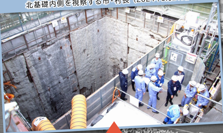
北基礎内側を視察する市・村長(2024年5月27日)
