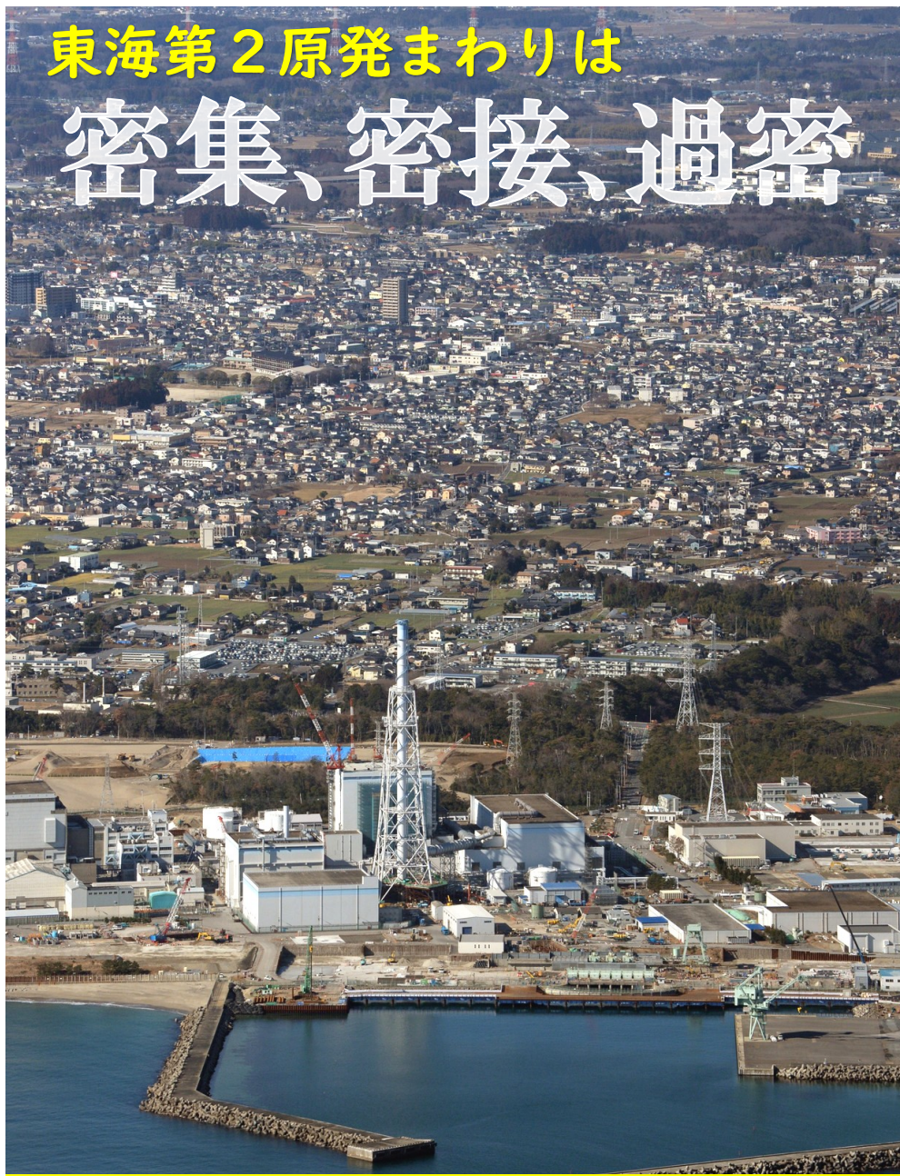
海側から見た東海第2原発（しんぶん赤旗チャーター機から撮影、2021年2月）
